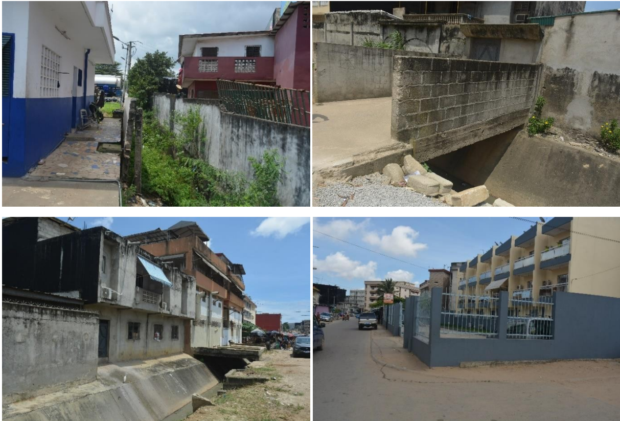
Planche 10 : Exemple de bâtis dans l'emprise du sous-projet
