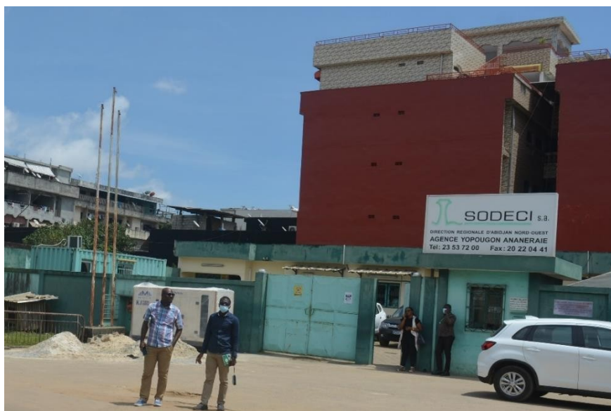
Photo 4 : Vue d'une agence de la SODECI à Yopougon, source GVGCS-CI.
