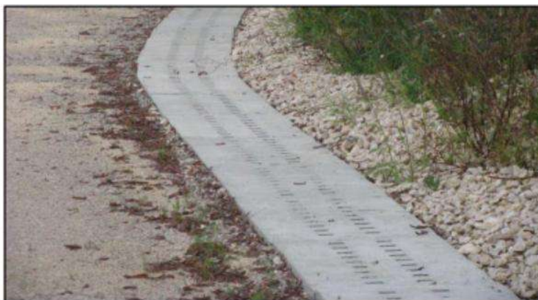
Photo 1 : Vue d'un caniveau à fente.
